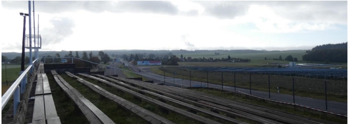
Blick in Richtung B 228 (nach Südost)
