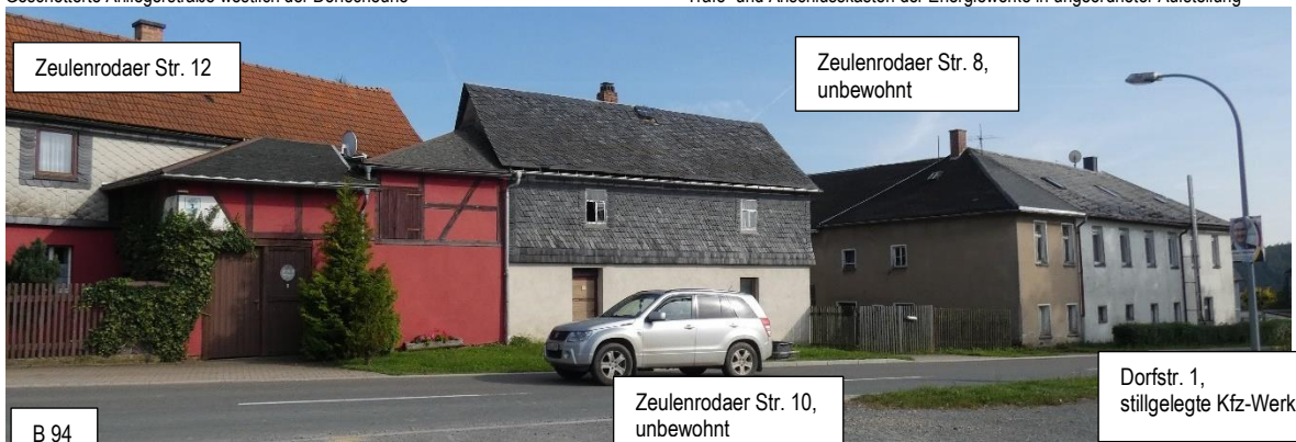
Dem Platz gegenüberliegende Straßenseite mit teilweise maroder Bebauung
