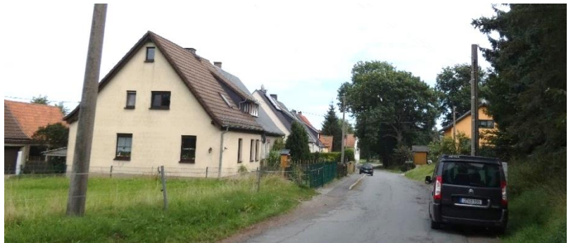
Einfamilienwohnhausbebauung 1972 – 1990 bis an die ehemals landwirtschaftlich genutzte Hofanlage, drei EW 65 Doppelhäuser Haus Nr. 1, 3, 5, 7, 9 11 und auf der anderen Straßenseite ein Einzelhaus Haus Nr. 2
