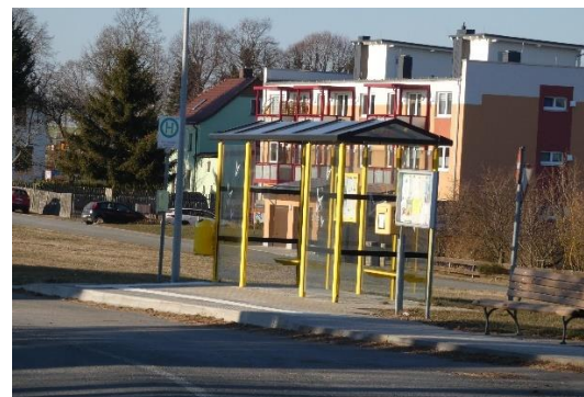
Oberböhmisdorf Wartehalle, Richtung Schleiz, barrierefrei
