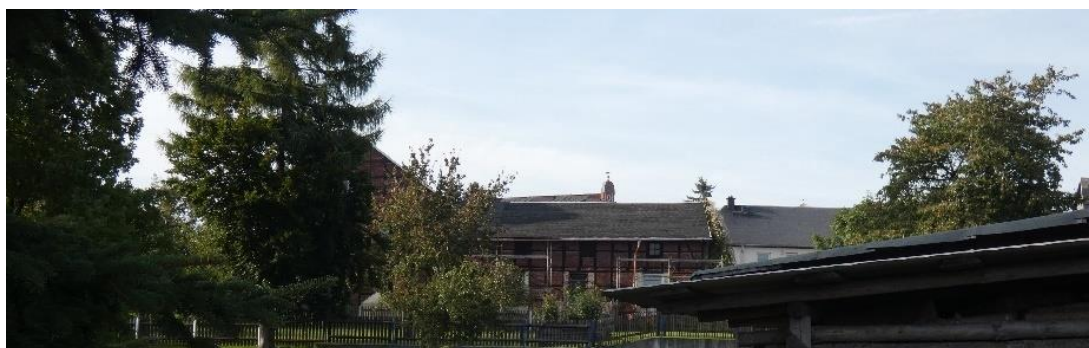
Blick vom Sportplatz auf Flurstück 51/1, mit Scheune + Wohnhaus Dorfstr. 24
