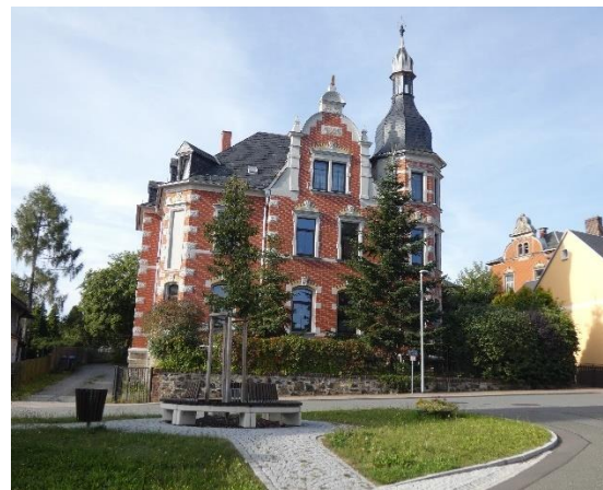
Sanierte Fabrikantenvilla, Haus Nr. 29 rechts im Bild, Giebel des die Folge der Klinkerfassaden unterbrechende kleine Wohnhaus Dorfstraße 31
