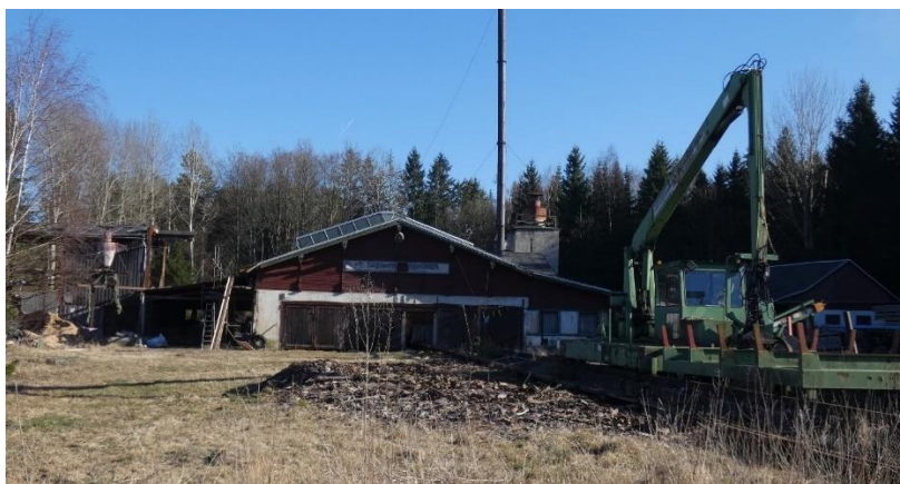
stillgelegtes Sägewerk im Außenbereich
