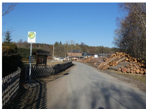
Nutzung des Straßenrandstreifens als Holzlager (Sägewerk) keine Gehwege, Gefahr für spielende Kinder auf den Holzstapeln, unbefestigter Bushaltepunkt ohne Schutz, ohne Wartemöglichkeit, nicht barrierefrei
