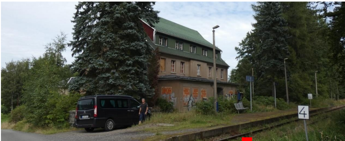
Blick von Süden (von der Gleisanlage) auf das Bahnhofsgebäude
