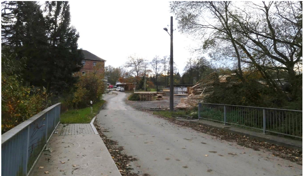
Blick von der Wisentabücke nach Süden auf das Holzlager auf Flurstück 2049/11 (recht im Bild) und auf das Verwaltungsgebäude mit Wohnung, Wisentaaue 12 links im Bild Archivaufnahme aus Januar 2021
