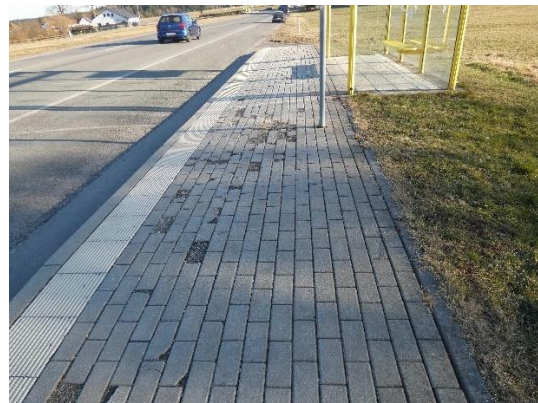
maroder Belag, barrierefrei, bei intaktem Belag barrierefrei erreichbar
