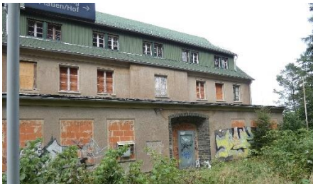
Detailansicht mit sichtbaren baulichen Sicherungsmaßnahmen (zugemauerte Fensteröffnungen) des ungenutzten Gebäudeteils
