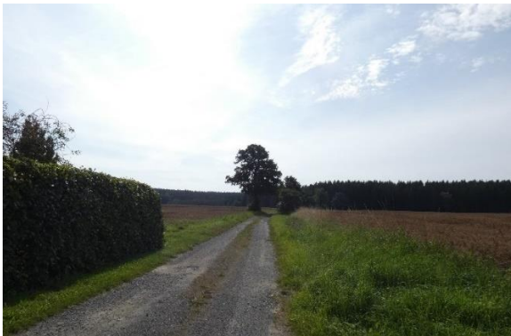
Fehlende und/oder vergraste Gräben an den Feldrändern und fehlende Felddraine verschärfen die Situation. Das Wasser läuft wegen der bestehenden Hanglage ungehindert über die Schotterstraßen hinweg und transportiert dabei Bodenmaterial von den Feldern in die tiefer liegende Ortslage.
