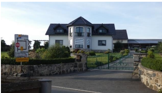
Wohnhaus Dorfstraße 9 (Bestandteil des Tiervermarktungsbetriebes .....)
