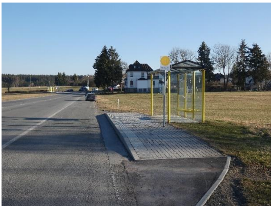
Oberböhmisdorf Wartehalle, Richtung B 228
