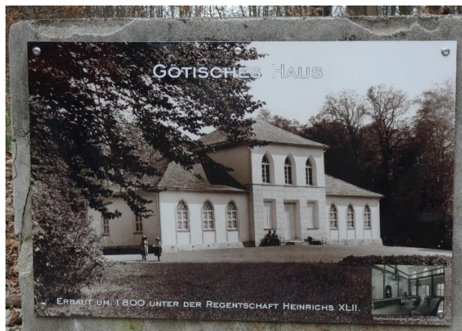
Tafel an der Grundmauer, siehe oben
