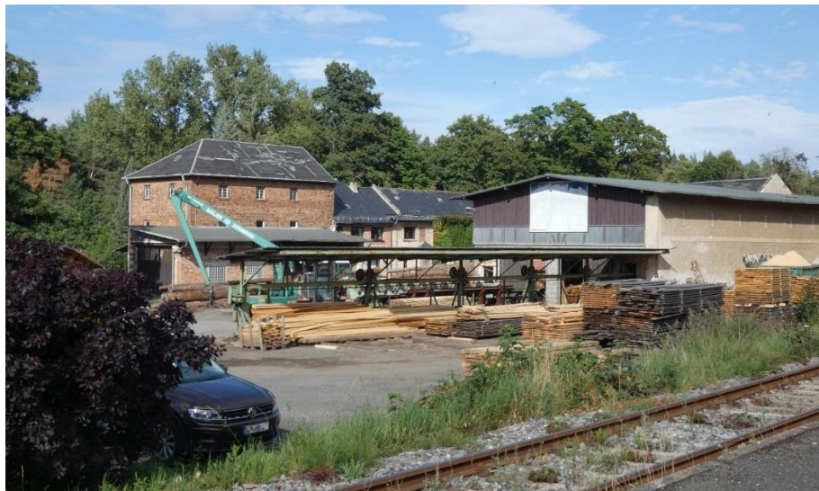
Bis an die Bahnlinie, rechts Bahnhofpunkt, heranreichendes Betriebsgelände des Sägewerkes
