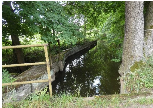
Mühlgraben an der Schmidtenmühle (Wisentaue)
