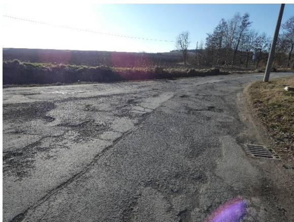
Verschlossene Straßendecke, fehlende Bankette, fehlende Borde, insbesondere zu den beiden Teichen (Überflutungsgefahr Straße)
