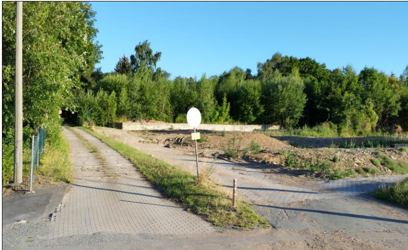
Abb. 2: Blick auf die öffentliche Zufahrt und die Abrissfläche des Flurstückes 1808/9
