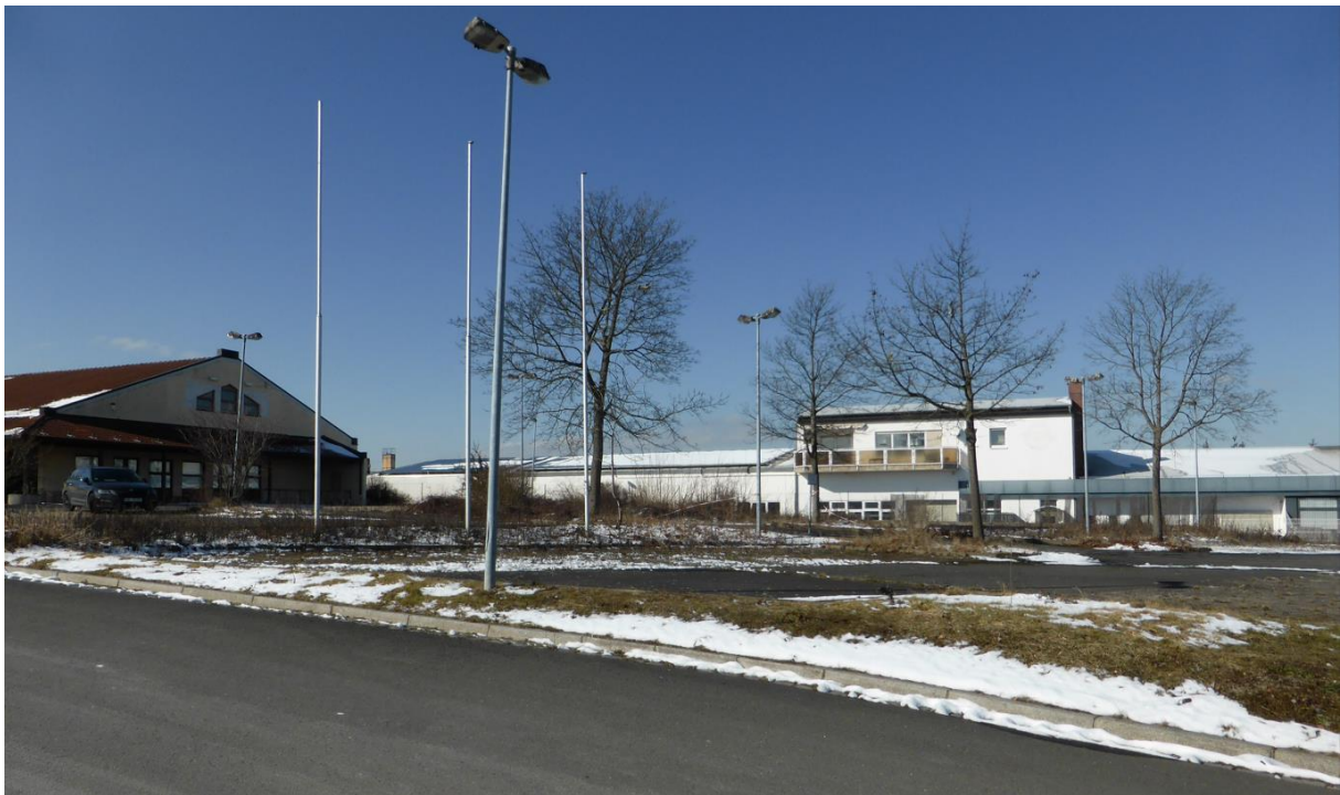
Abbildung 10: Das Plangebiet mit den bestehenden Gebäuden (links der ehemalige Einrichtungsmarkt, im Hintergrund das leergezogene Autohaus) – Blick von Osten über die Privatstraße
