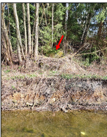
Abb. 12: Ende der Verrohrung (Pfeil) oberhalb der Wisenta
