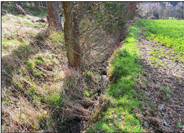
Abb. 10: Entwässerungsgraben zwischen Ackerrand und Fichtenwald
