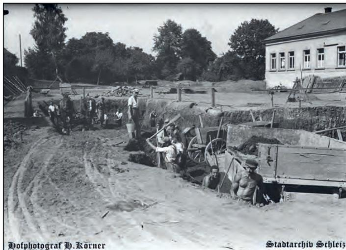
Foto: Fundamentarbeiten für den Bau des Postamts (Hofphotograph H. Körner)
