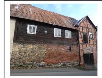
Denkmal Wohnstallhaus Holzgasse 1
