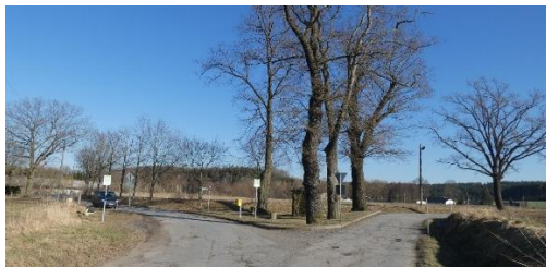
vorhandene Bushaltestelle mit Bushäuschen
