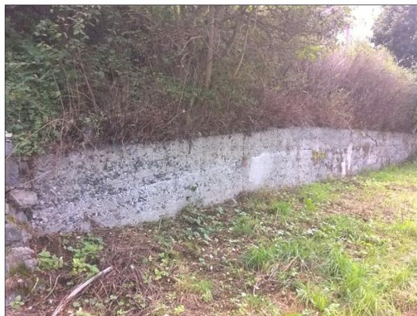
Abb. 45: mit Beton abgefangene Böschung am Projektstandort
