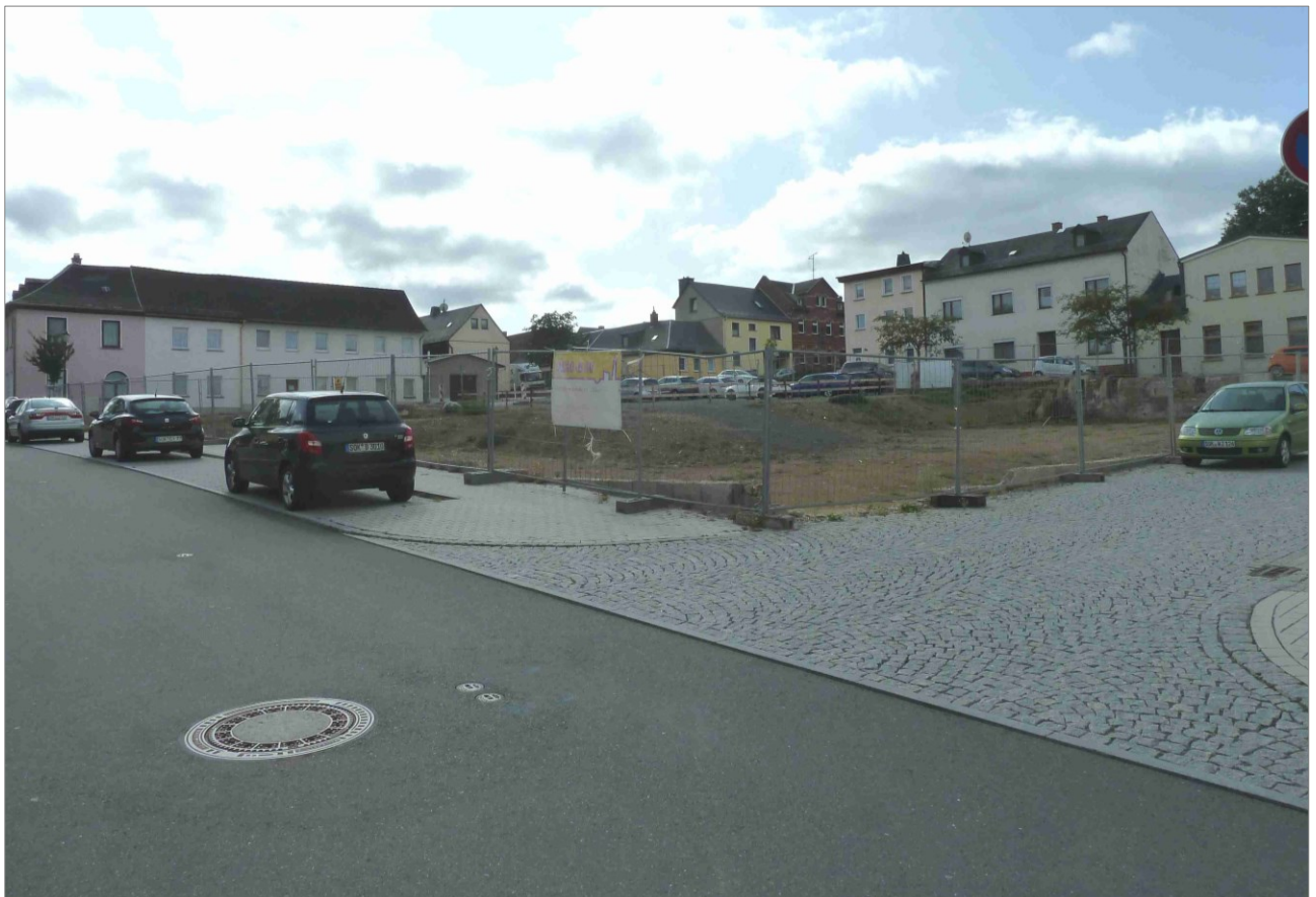
Bestandsansicht Liegenschaft von Norden
