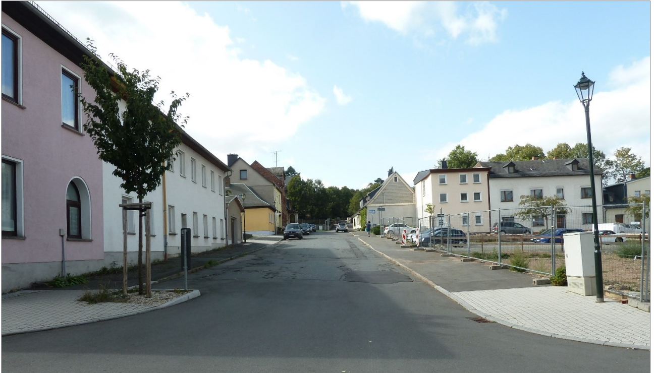
südöstlich angrenzende Baumgasse mit Bestandsbebauung
