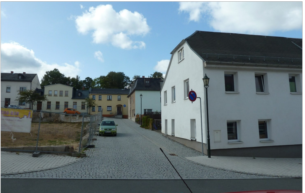
nordwestlich angrenzende namenlose Straße mit Bestandsbebauung
